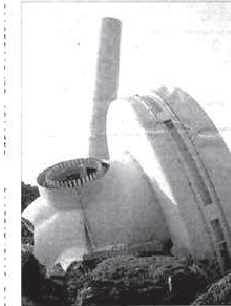
Par mesure de précaution, la digue Carnot du Portel, au pied des éoliennes, a été fermée au public. (Photo: La Voix)
